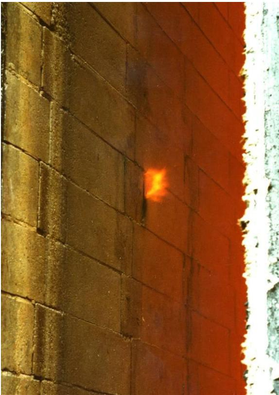
Abb. 45: Kokerei Gneisenau, 1984. Wird die Undichtigkeit der Heizwand nicht kurzfristig beseitigt, drohen größere Schäden.
