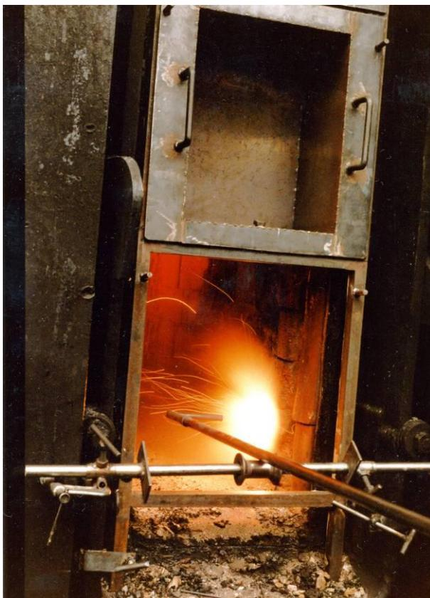
*Abb. 47: Reparatur eines Heizwandschadens durch keramisches Schweißen.*
