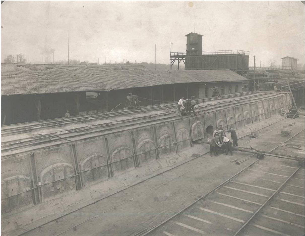
*Abb. 30: Kokerei mit Bienenkorböfen, o. D. Handbetriebene Druckeinrichtung und zwei mit einem Seil verbundene Türkabel. Vermutlich bestand ohne dieses Abspannseil Absturzgefahr wegen der einseitigen Belastung durch das Gewicht der Ofentüren (© DBM/montan.dok).*
