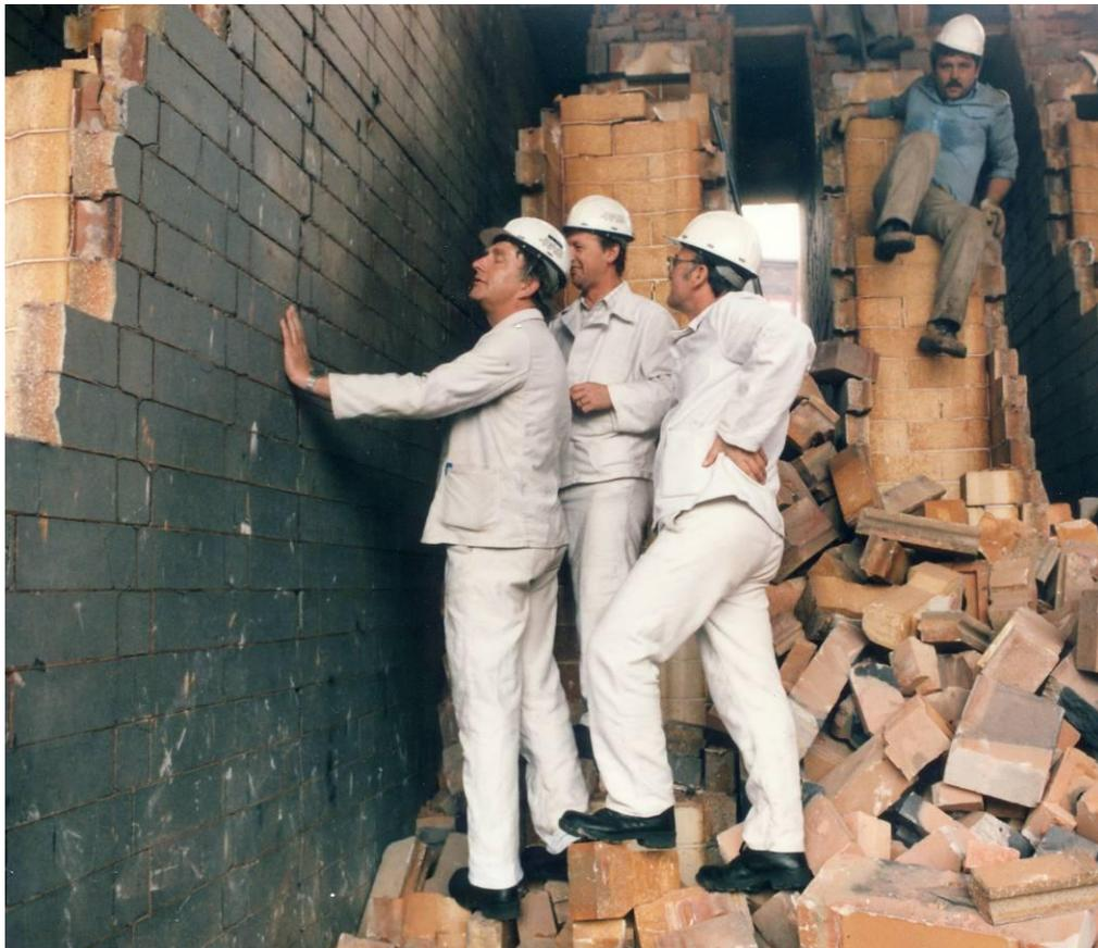
*Abb. 5: Kokerei Kaiserstuhl II, 1985. Betriebsführer und Fahrsteiger schauen sich während der Abtragung der Batterie C Wandschäden an, die zur Grunderneuerung der Batterie geführt hatten. Der Amateurfotograf hat, als er Wandschäden fotografieren wollte, im Vorbeigehen auf den Auslöser gedrückt (Archiv W.-D. Koßke).*
