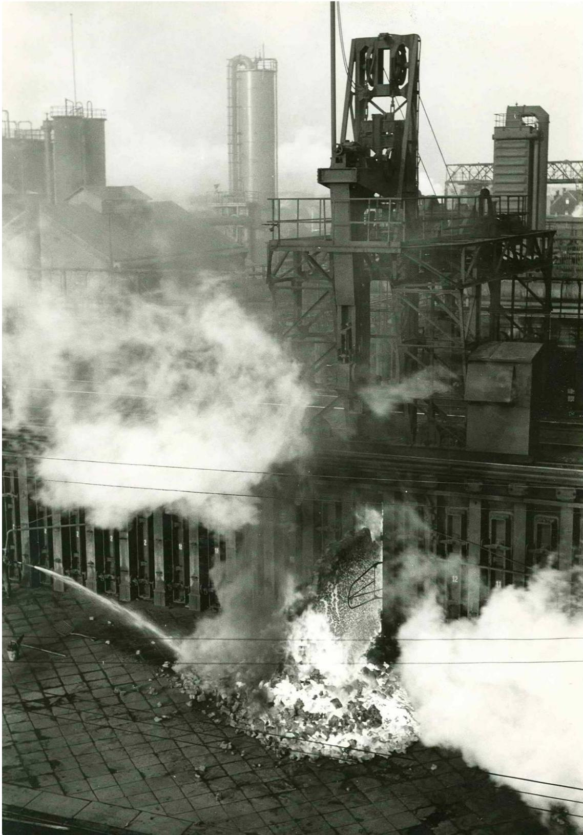
*Abb. 31: Kokerei Helene, o. D. Maschine auf der Ofendecke zum Hochziehen der Koksofentüren auf der Koksseite und der Maschinenseite. Eine riesige Konstruktion, die den Füllwagen wie eine Kranbrücke überspannt.*
