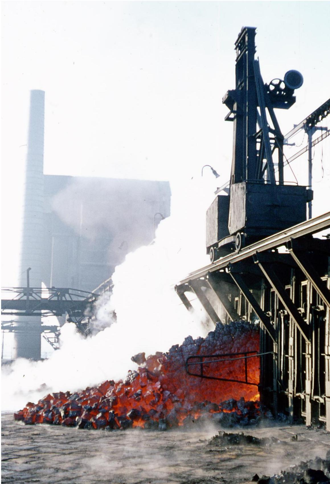
Abb. 32: Kokerei Emscher-Lippe 3/4, 1975. Türkabel auf einer Fahrbahn seitlich der Ofendecke. Durch die seitliche Verlagerung der Türkabelfahrbahn liegt der Lastangriff beim Heben der Ofentür in der Mitte der Fahrbahn.
