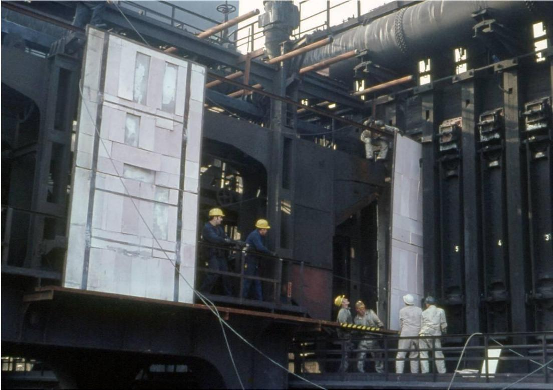
Abb. 48: Kokerei Kaiserstuhl II, 1970. Isolierwände in zwei Ofenkammern ermöglichen den Abbruch und den Neubau der Zwischenwand.
