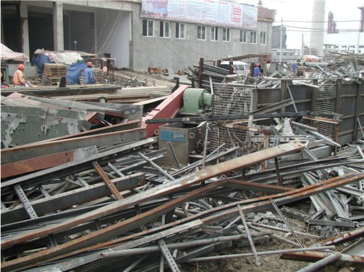
Abb. 9: „Wie der Abbruch so der Wiederaufbau“
