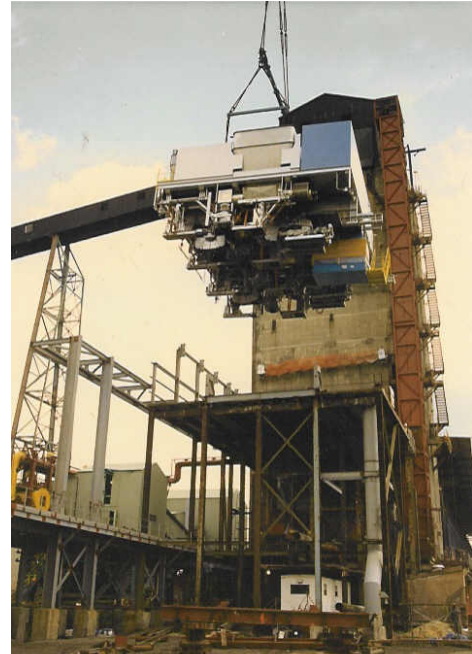
Abb. 6: Positionierung des Füllwagens
