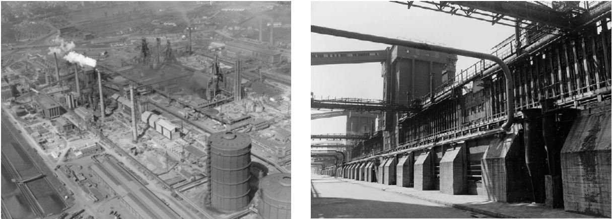
Bild 13: Kokerei-Neubau im spanischen Hüttenwerk Aviles. links: 2. und 3. Baustufe in den Jahren 1964 / 68; rechts: nach der Fertigstellung
