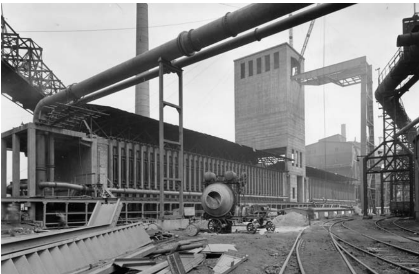
Bild 14: Anheizen der Batterien A/B der Kokerei Kaiserstuhl II im Jahre 1953
